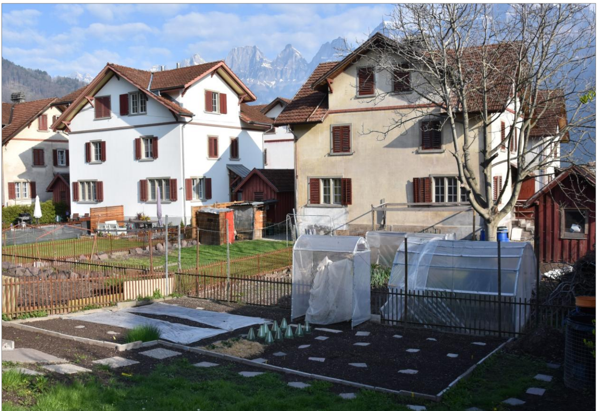
Historisch bedeutungsvolle Arbeitersiedlung von nationaler Bedeutung (Foto: Innobas AG)
